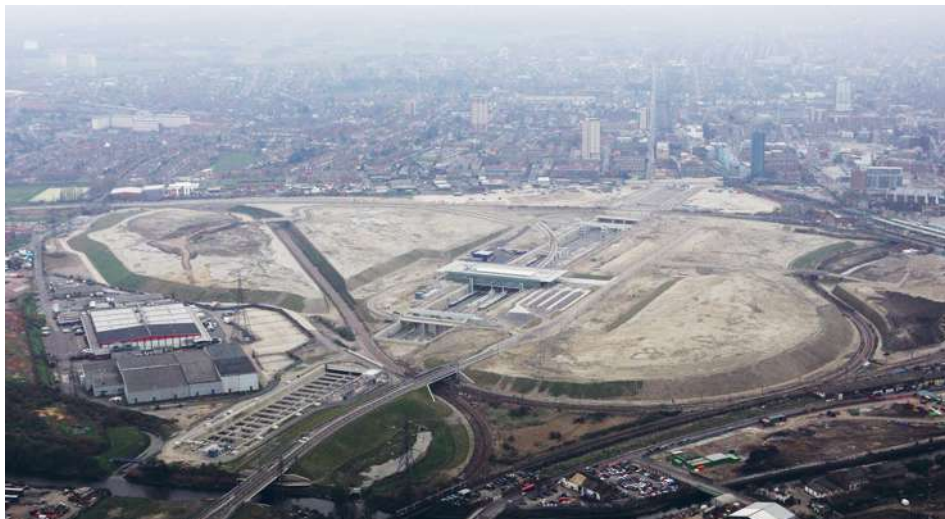
↑ Stavební práce na Olympijském parku ve Stratfordu – hlavního střediska her v Londýně v roce 2012.
